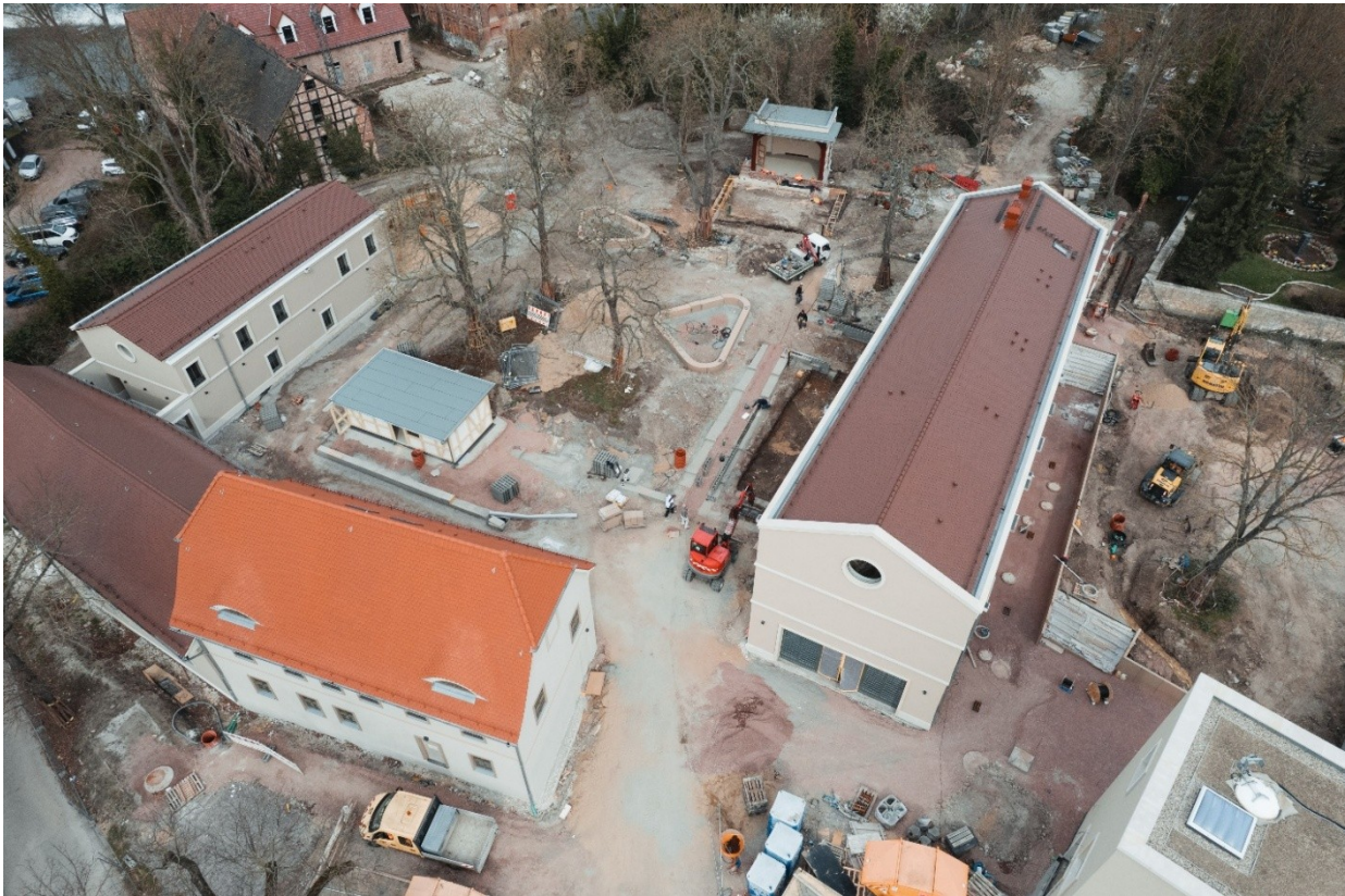
Luftansicht: Der Kaffeegarten Am Mühlwerder. Auf dem Gelände gut sichtbar sind der historische Musikpavillon (Bildmitte hinten) und der neue Ausschank-Pavillon (linke Bildhälfte Mitte). Foto: GWG Halle- Neustadt
