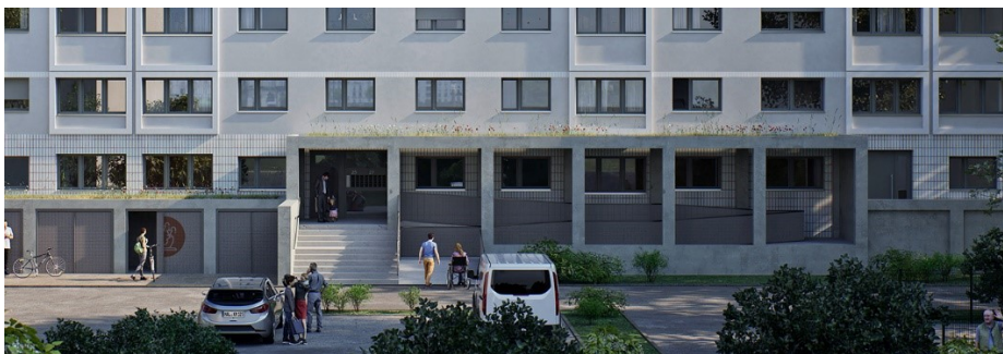
Bildunterschrift: Der neue zentrale Eingangsbereich mit einer Treppen- und barrierefreien Rampenanlage. Links davon ordnen sich die von außen zugänglichen Fahrradboxen mit mehr als 40 Stellplätzen an Bildquelle: Martin Hocke, mh Visualisierung
