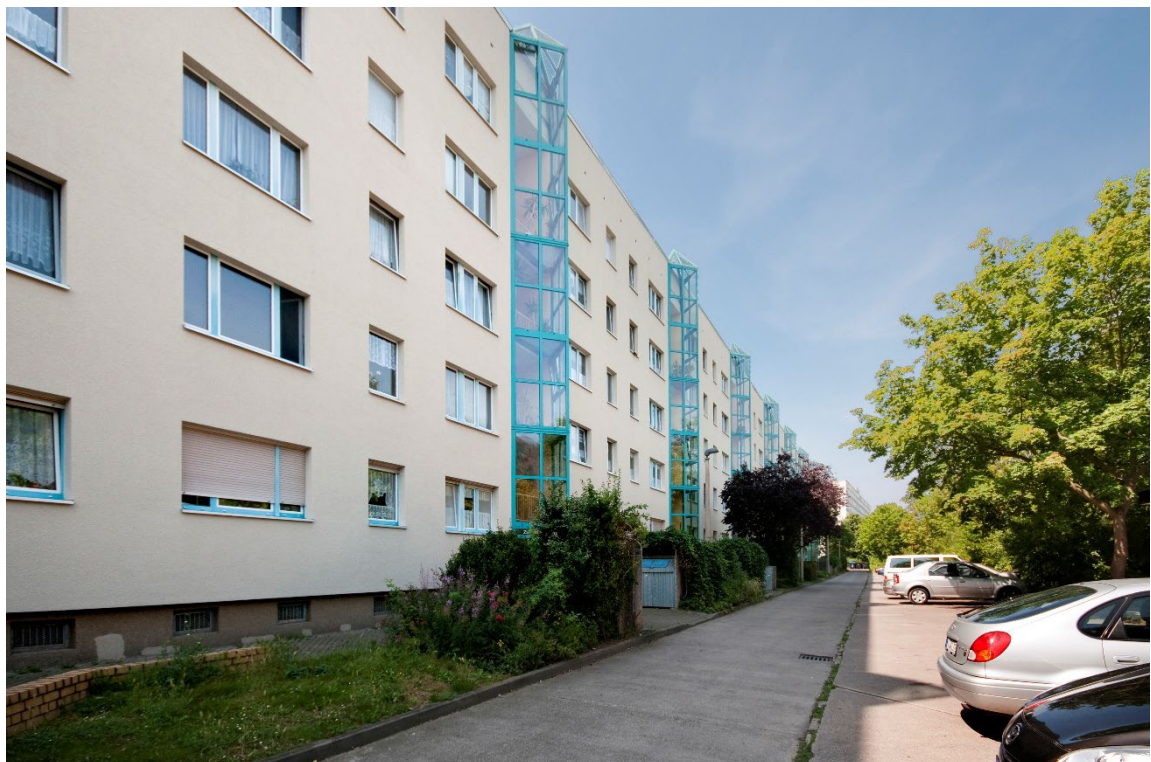
In der Zscherbener Straße 3- 10 entsteht ein weiteres KfW-Effizienzhaus 70 im Bestand der GWG. Foto: GWG Halle-Neustadt
