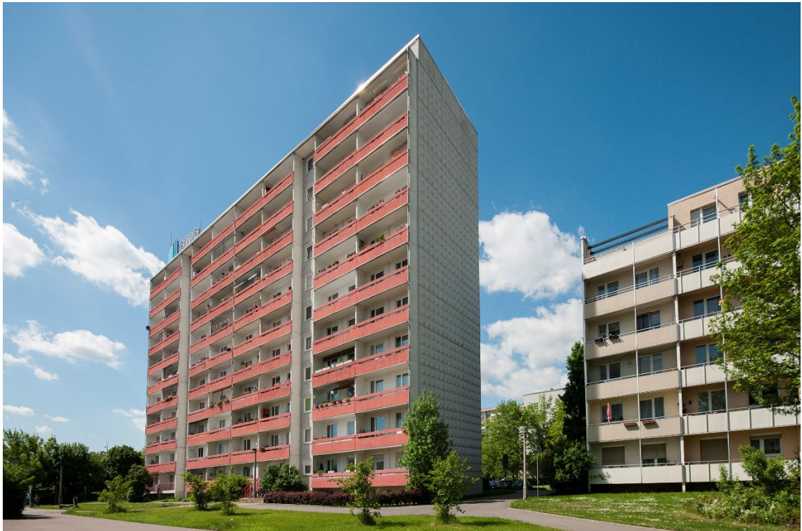
Das Sanierungsobjekt in der Hyazinthenstraße. Foto: GWG Halle-Neustadt
