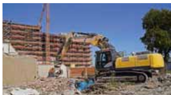
Der Teilabriss des Speichers ist geschafft.
